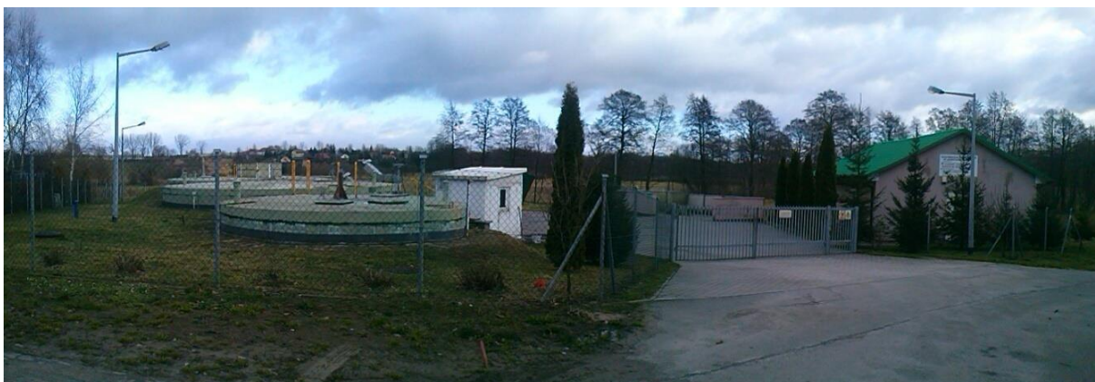
Rysunek 13. Oczyszczalnia ścieków – Jankowo Dolne
